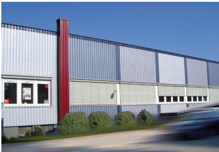
Allen Wettern zum Trotz: Metallbauteile im Außenbereich werden mit LUCITE® 2K-EpoxyPrimer farbig grundiert und mit den UV-stabilen 2K-Buntlacken effizient schlussbeschichtet. Das Epoxidharz-System garantiert zuverlässigen Korrosionsschutz.
